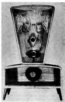
Rys. 7. Rozmieszczenie głośników w obudowie
